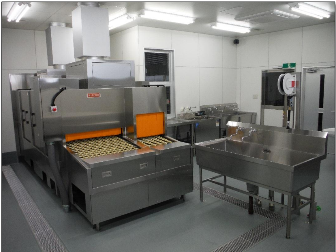
【洗浄室】 中央に食器・食缶洗浄機、奥にはスプーン洗浄機等も設置されています
