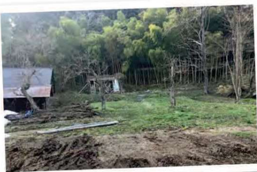
柏倉家の崩れかけた炭小屋。昔は敷地の北側にも建物があったそうです。
