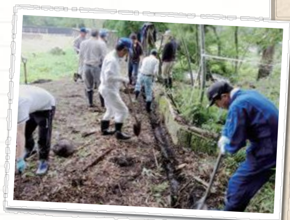
9月に実施した水路の掘り出し作業の様子
