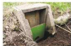
田んぼダム（排水樹に調整板を設置）
