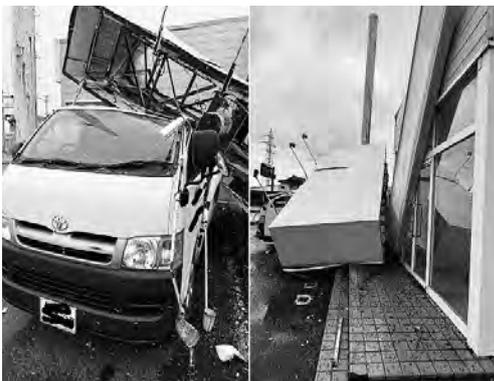
老朽化した看板が強風で落下し車が破損した事例
