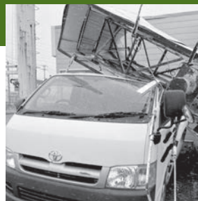
令和5年 県内の事例 老朽化した看板が強風で 落下し車が破損した
