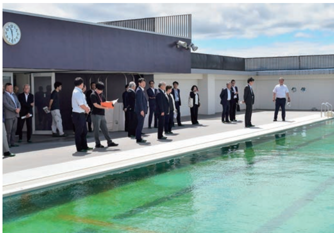
体育館屋上に整備されたプール
