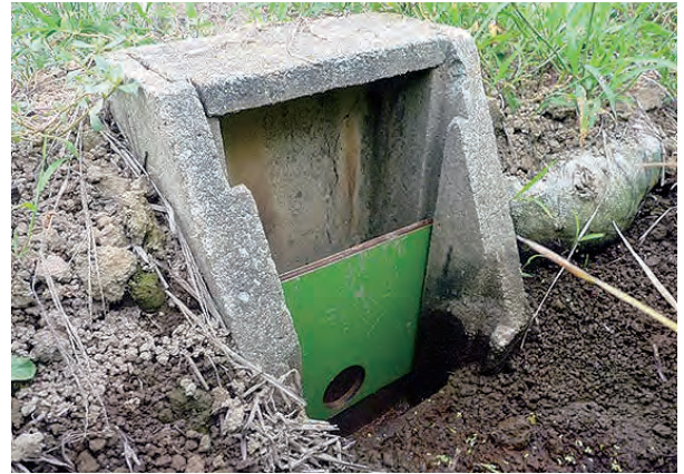
調整板を設置した様子
