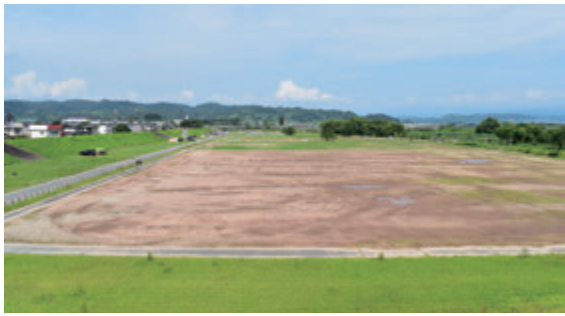
▲復旧作業が終わり、きれいに整備されました
