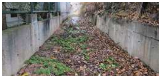
長崎堰（旭町地内）
