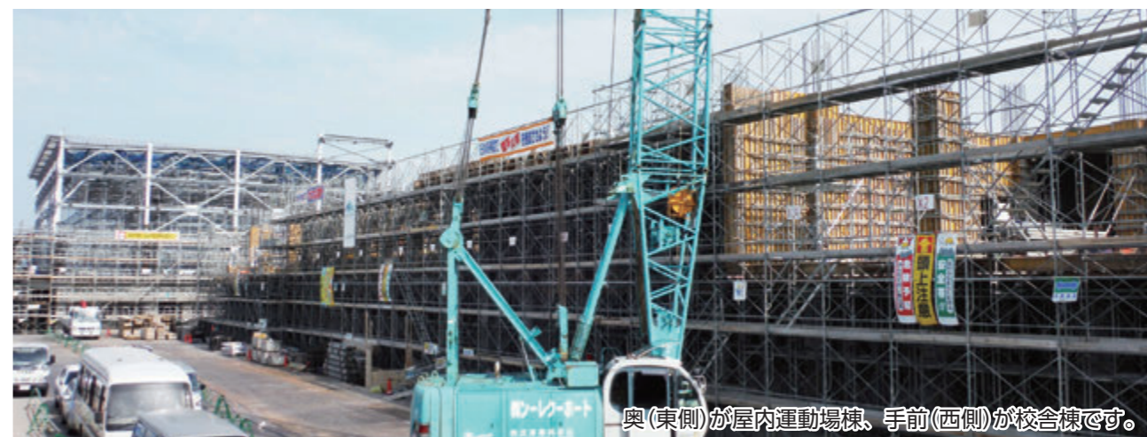
屋内運動場棟外観(南西側)
