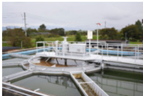
沈殿池。1日8,500m 3 の原水を処理できる。
