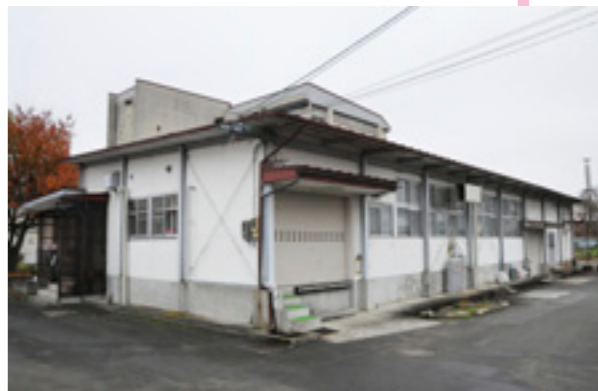
現在の学校給食共同調理場(中山中学校敷地内西側)
