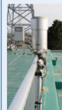
役場屋上に設置してある雨量計
