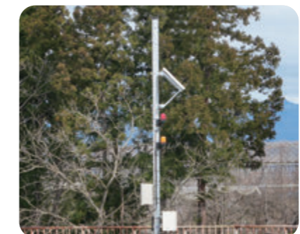
石子沢川排水機場パトランプ点灯システム 赤色…最上川の水位が計画高水位を超過し、排水停止 黄色…石子沢川排水機場が稼働
