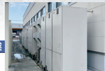
4ユニットあるエコキュートのうち 2台を交換します
