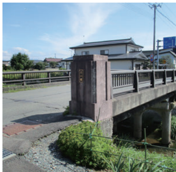
改修工事が決定した北小路「古川橋」
