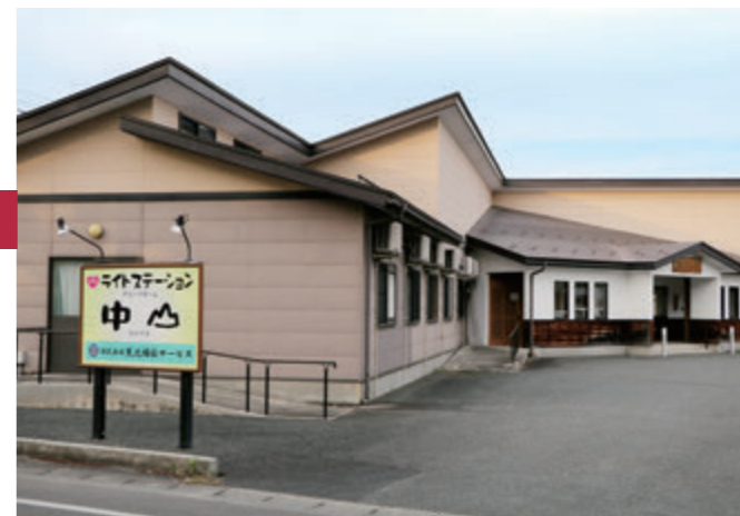
改修計画が進むライトステーション中山
