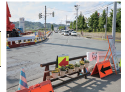
ようやく完成へ（国道458号 県野球場前交差点）
