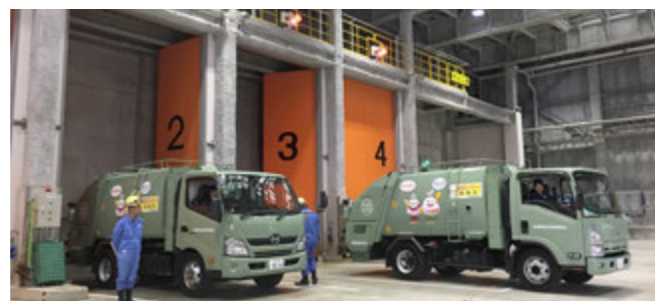
稼働中のエネルギー回収施設（立谷川） ごみ投入口
