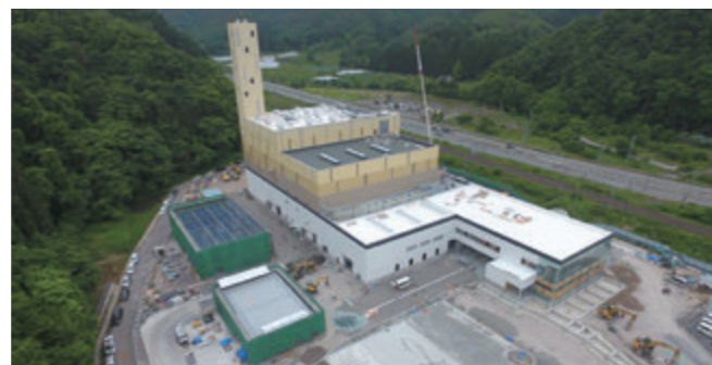
完成間近のエネルギー回収施設（川口） 外観
