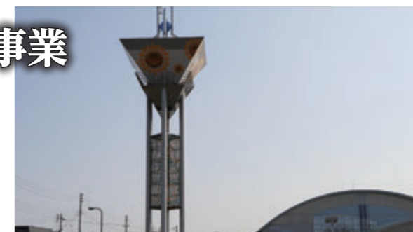
町看板とあわせて改修工事を行うゆ・ら・ら鉄塔
