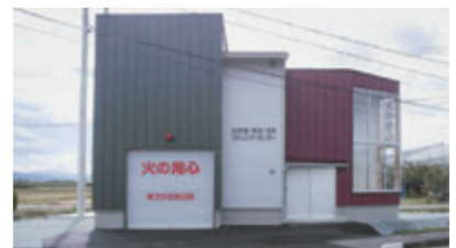
今年度完成した三軒屋・落合地区防災コミュニティセンター
