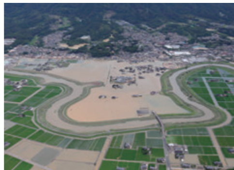
令和3年大雨による被害状況
