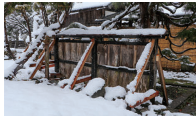
寄附金を活用し修繕された敷地内板塀
