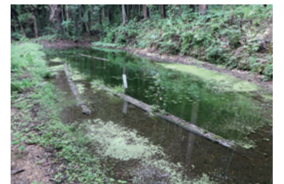
湿気対策として池の浚渫工事を予定しています（九左衛門家屋敷裏にあるため池）
