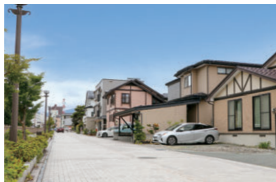
空が広く見える無電柱化された住宅街 (山形市城南町)
