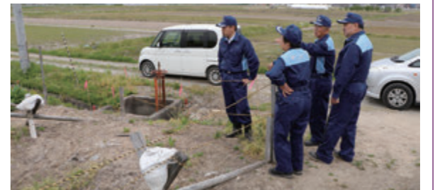
長崎堰取水口付近
