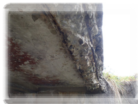
▲ 凍害損傷
