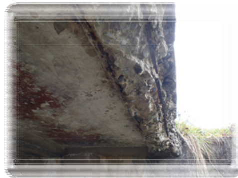
▲ 凍害損傷
