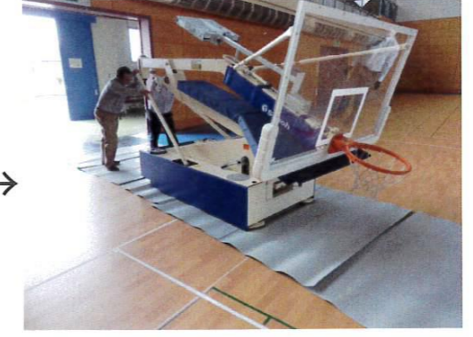
④⑤移動式バスケット台移動 養生材の上移動させる
