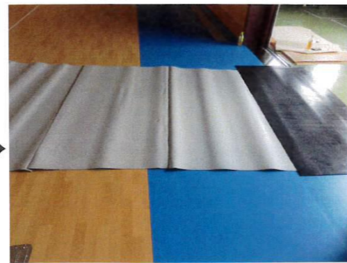
②荷重用養生材敷き込み 重ね部分向き注意(手前を上を重ねる)
