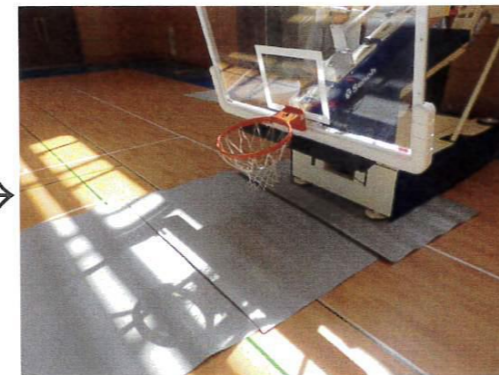
⑫(戻り) 荷重用養生材敷き込み 重ね部分向き注意(手前を上を重ねる)
