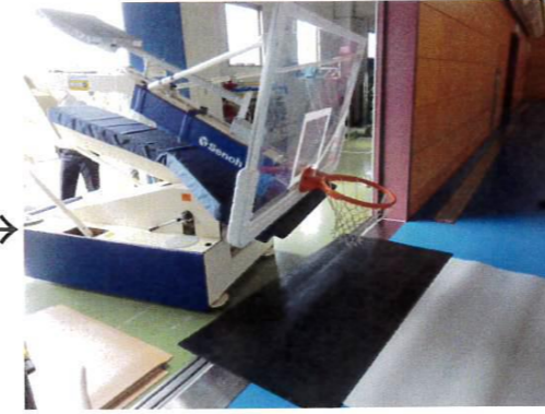
④⑤移動式バスケット台移動 養生材の上移動させる
