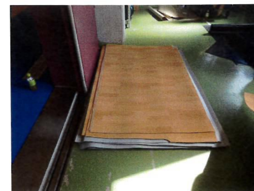
⑯重石用のフローリングシートを置く
