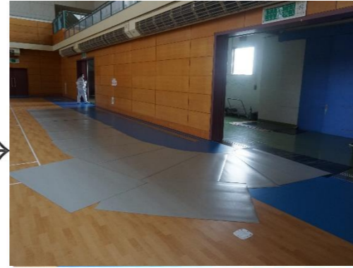
③荷重用養生材敷き込み
