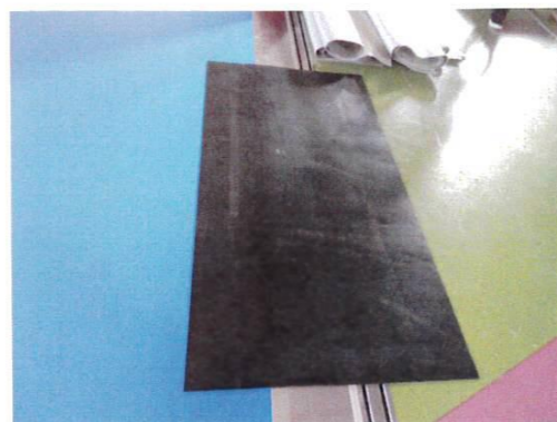
①ステンレス床見切りにゴムシート引く
